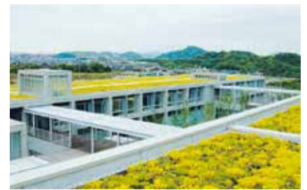
セダム緑化システム(現場植えタイプ)
