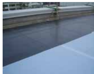
オルタックシート貼り
